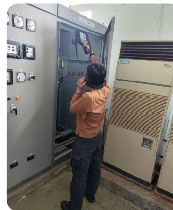
▶ 圖 5-23、企業損防顧問電氣設備安全檢測（超音波）
